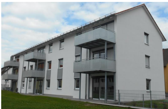
Mehrfamilienhaus Lessingstraße Abbruch und Neubau 2012 / 2013
