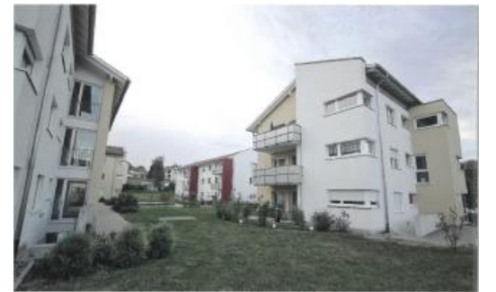
Goldrainstr. 2 + 4 heute Abbruch und Neubau 2006 / 2007
