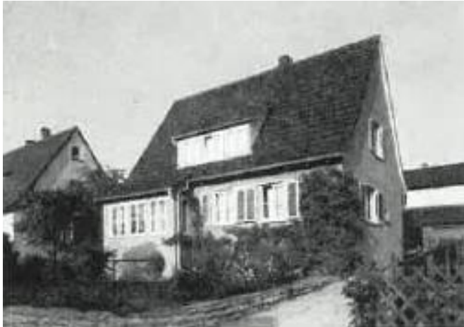
Einfamilienhaus Mittelhof Alfing-Siedlung Baujahr 1943
