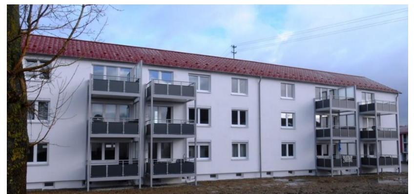
Mehrfamilienhaus Königsberger Straße Nach der Sanierung 2016 / 2017
