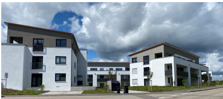
Mehrfamilienhäuser Schillerstraße / Abt-Kuno-Straße Abbruch und Neubau 2019 / 2020
