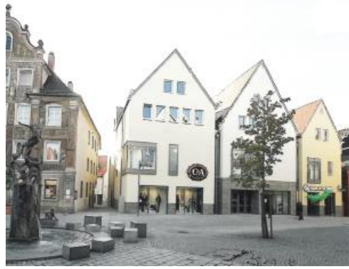
Oben: der alte Gasthof „Weißer Ochse“ und das Haus „Metzger“ Unten: der fertige Neubau 2009 / 2010
