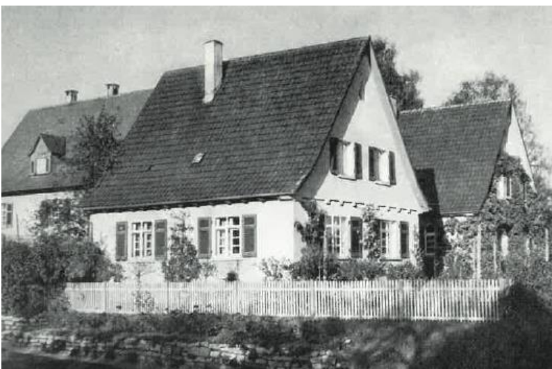
Einfamilienhaus Haller Straße, Baujahr 1926
